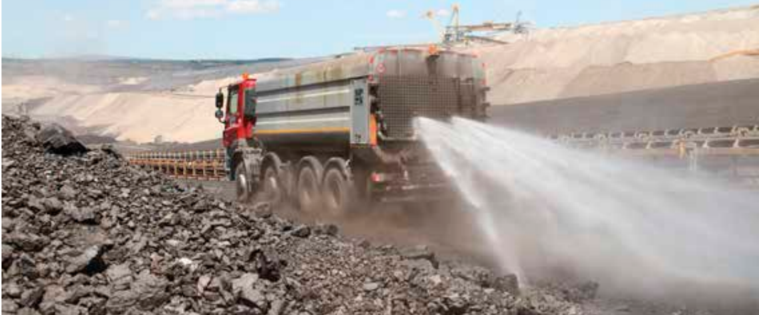
Jedno z účinných protiprašných opatření v uhelném lomu Bílina – zkrápění komunikací.
