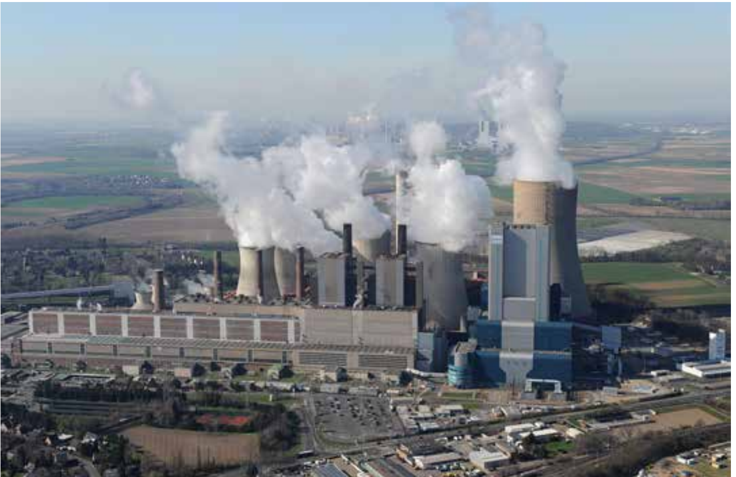
Obr. 2: Elektrárna Niederaußem, jejíž bloky E a F budou v letošním roce v Německu převedeny do bezpečnostní rezervy. Zdroj: RWE Power AG
