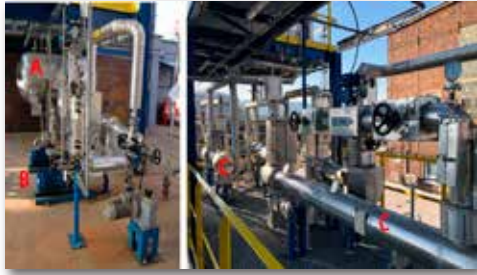
A - zásobník suroviny, B - čerpadla; C - výměníky tepla
