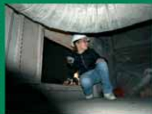
Školákům se během exkurzi v teplárně Komořany otevírají mnohá tajemná místa – například se dozví, jak to vypadá uvnitř obrovského kotle.
