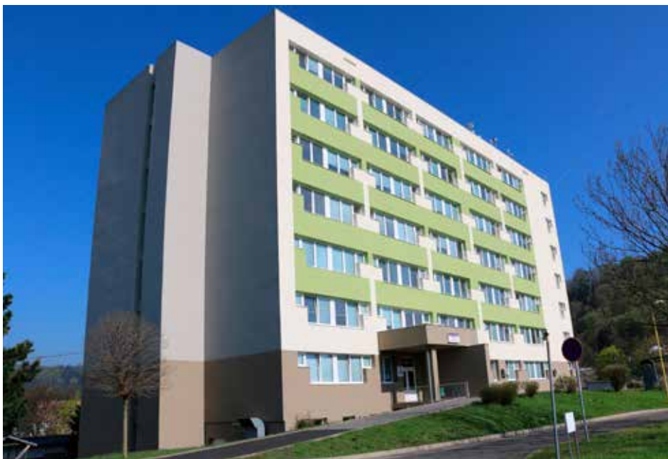
Pavilon interních oborů děčínské nemocnice po revitalizaci.
