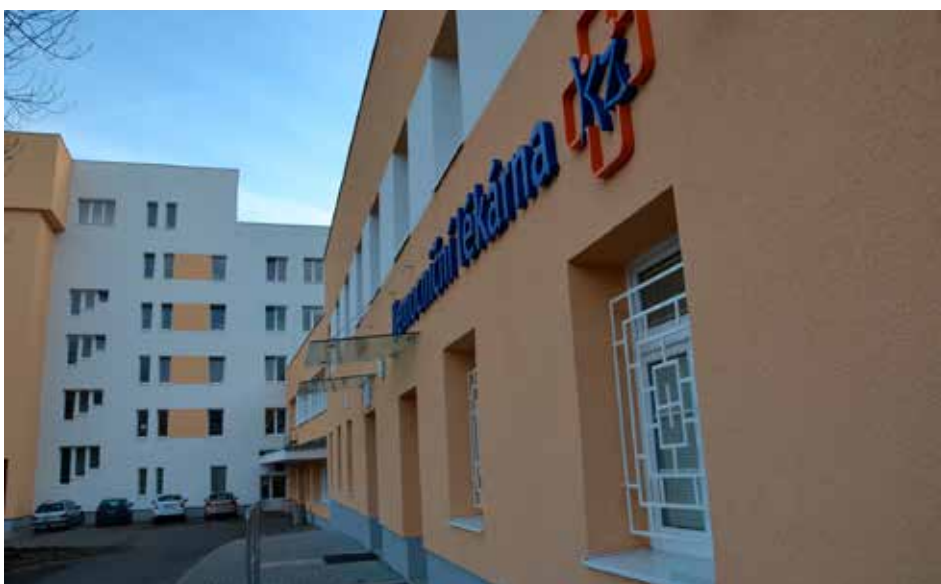
Centrum komplexní onkologické péče Masarykovy nemocnice v Ústí nad Labem v Podhájí s novou Nemocniční lékárnou KZ.
