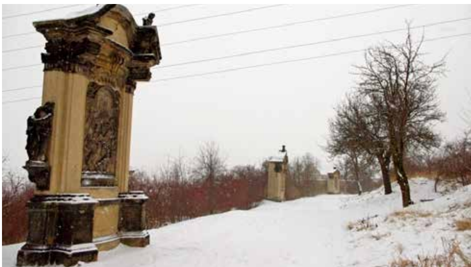
Unikátní snímek ze zimy 2010 lokality Vtelno s kaplemi, přesunutými záchranným transferem – foto Ondřej Přerovský
