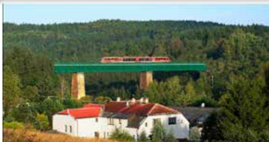
Rekonstrukce mostu v km 21,502 trati Rumburk (mimo) – Sebnitz (DBAG)
