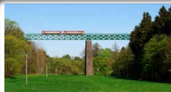
Rekonstrukce mostu v km 21,502 trati Rumburk (mimo) – Sebnitz (DBAG)
