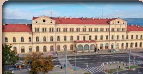
Investiční akce výpravních budov v Ústeckém kraji
