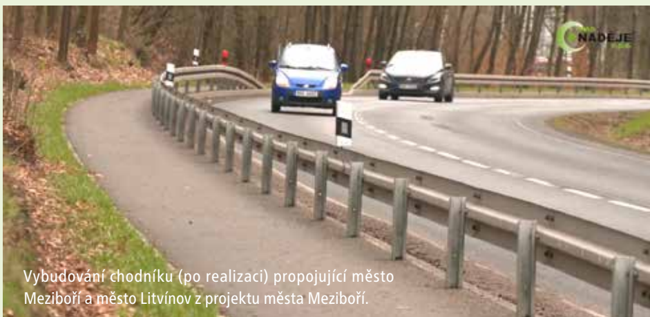
Vybudování chodníku (před realizací) propojující město Meziboří a město Litvínov z projektu města Meziboří.
