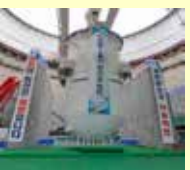
Instalace reaktorové nádoby prvního bloku nové elektrárny Shin Hanul (Jižní Korea)
