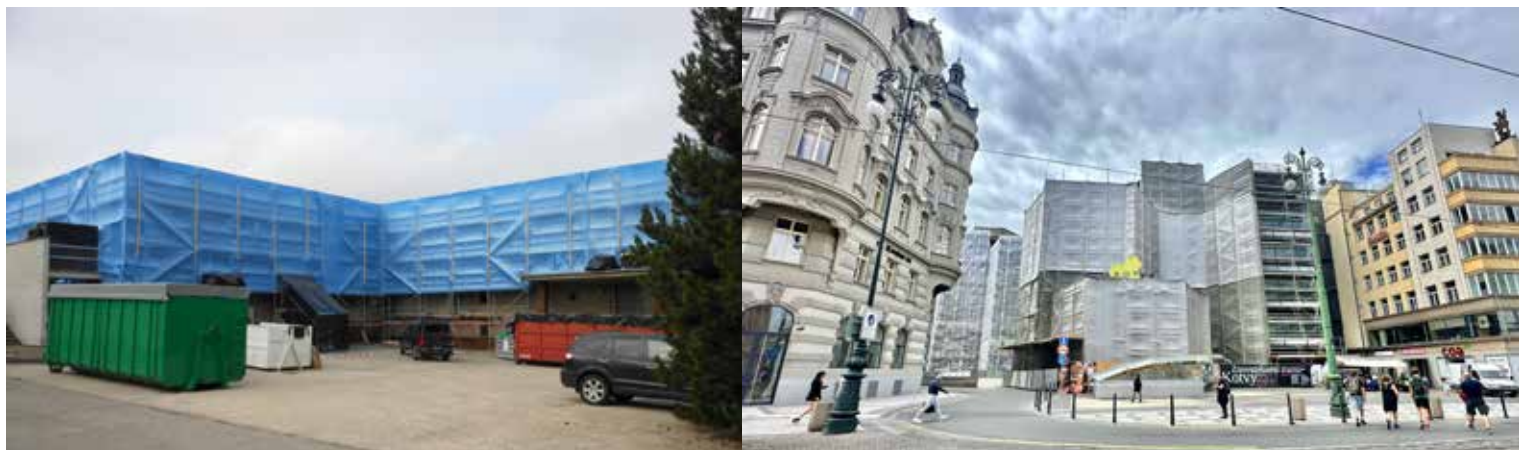
Uzavřené kontrolované pásmo (KP) s podtlakem v rozmezí -20 Pa až -40 Pa (optimálně -30 Pa) s minimálně čtyřnásobnou výměnou vzduchu za jednu hodinu při provádění inspekce účinnosti sanace azbestu oprávněným inspekčním orgánem v roce 2012 a 2025, jedná se o tzv. kontinuální kontrolu inspektory oprávněného inspekčního orgánu, že v průběhu sanace azbestu nedochází k úniku azbestových vláken mimo vytvořené uzavřené KP a je dodržován ohlášený návrh technologického postupu sanace azbestu a všechna azbestová zátěž je odstraněna (fotodokumentace archiv Foster Bohemia s. r. o.).
